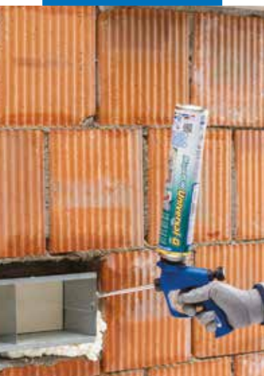
Relleno de conducto de ventilación
